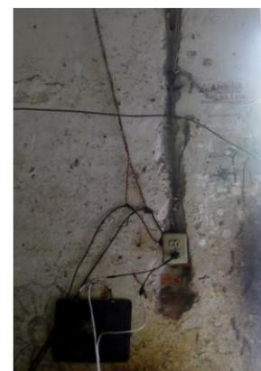
Para evitar los accidentes, es muy importante realizar revisiones periódicas, mantenimiento y remodelaciones en las instalaciones eléctricas; considerando especialmente el reemplazo de los conductores eléctricos viejos y deteriorados por aquellos que están dimensionados de acuerdo a los actuales requerimientos, así como la incorporación de dispositivos y elementos de protección complementarios.
